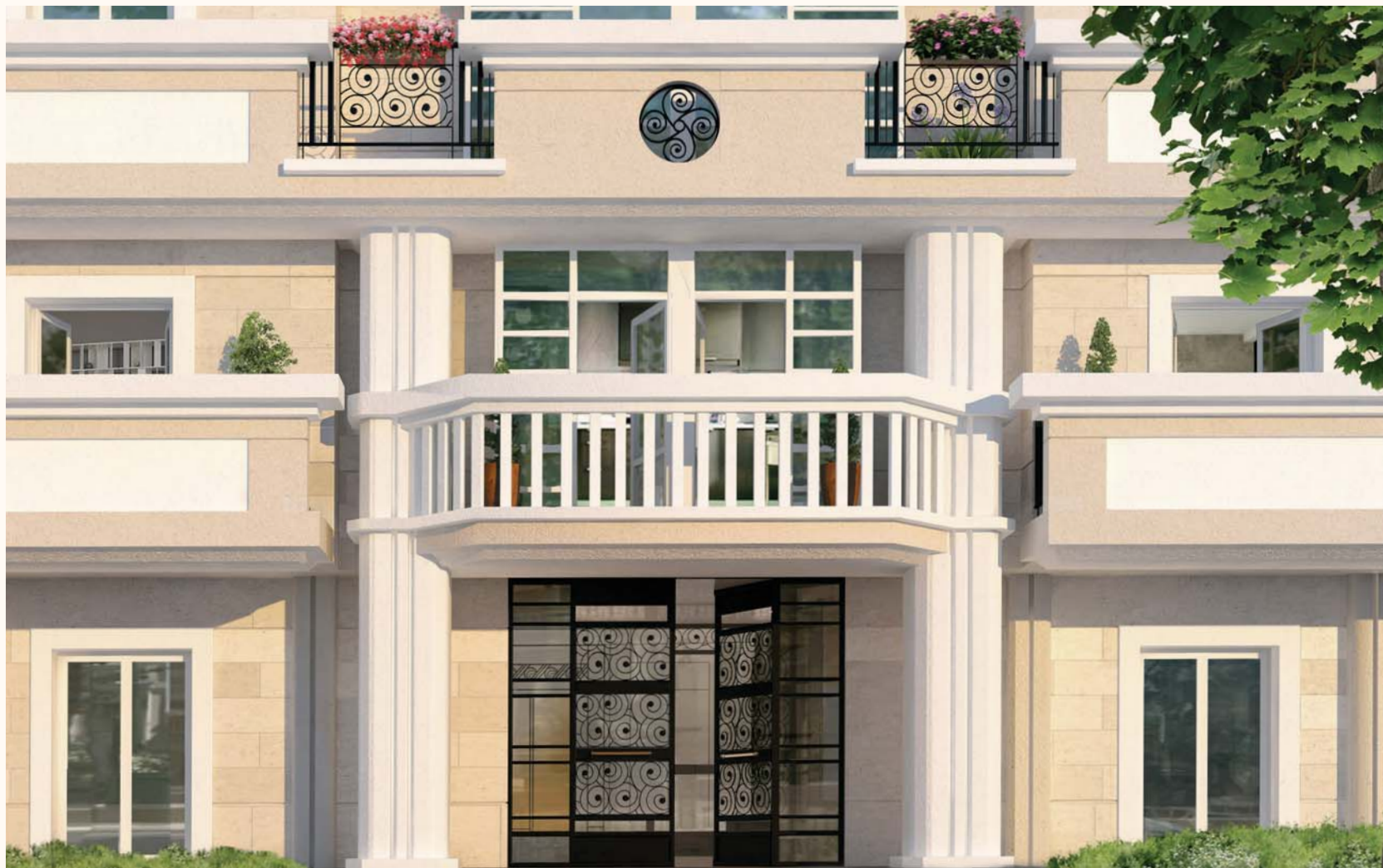
Entrée de la résidence Neuilly la Grande Jatte.
