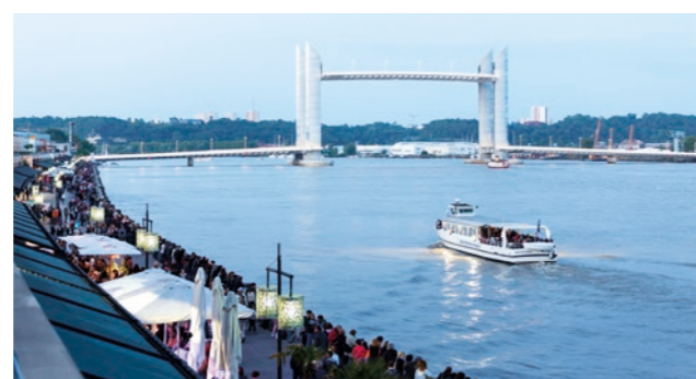
Le pont Jacques-Chaban-Delmas est un pont levant franchissant la Garonne.
